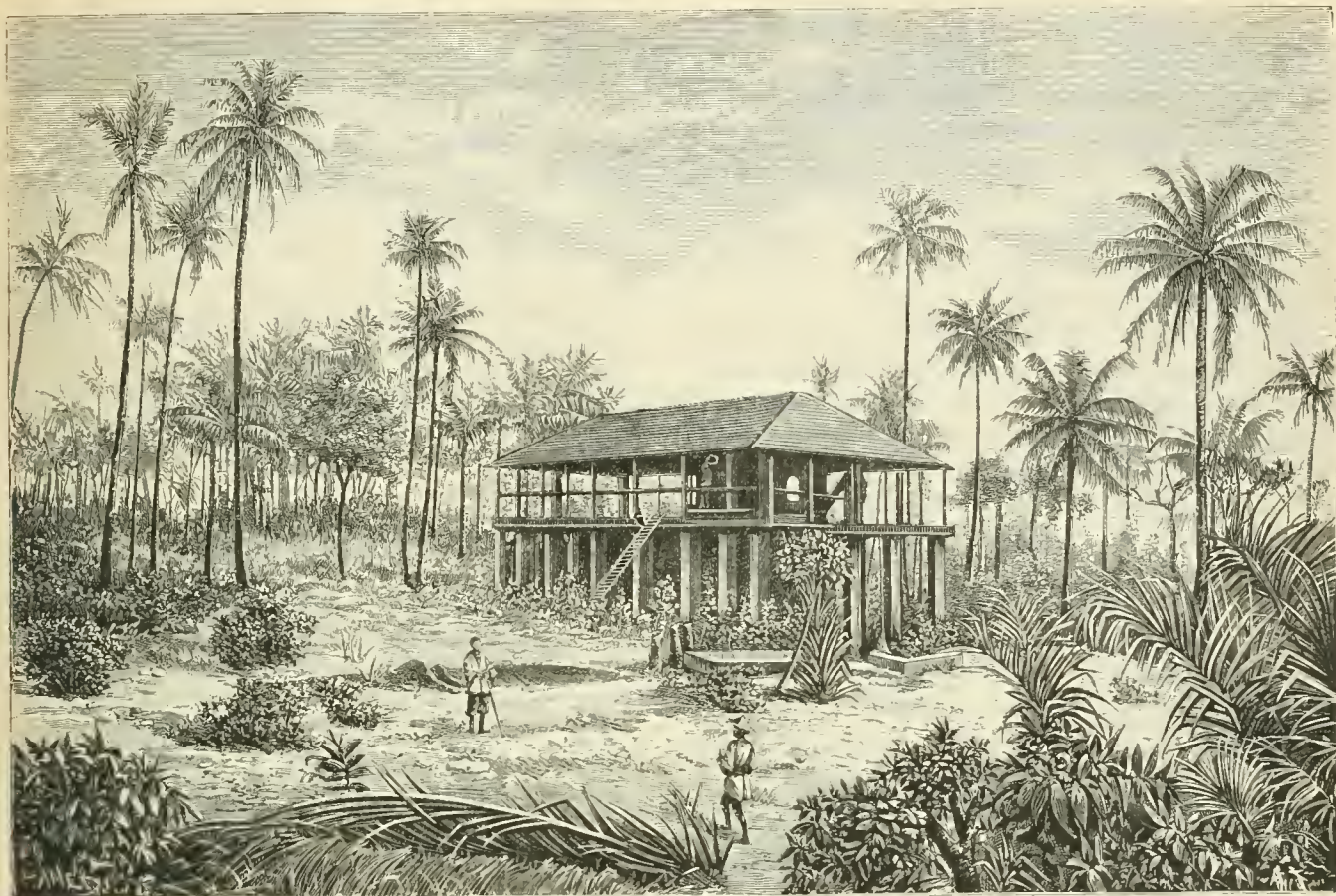
SIERRA-LEONE. — MAISON DE CONAKRY EN CONSTRUCTION; d'après une photographie. (Voir page 614.)
